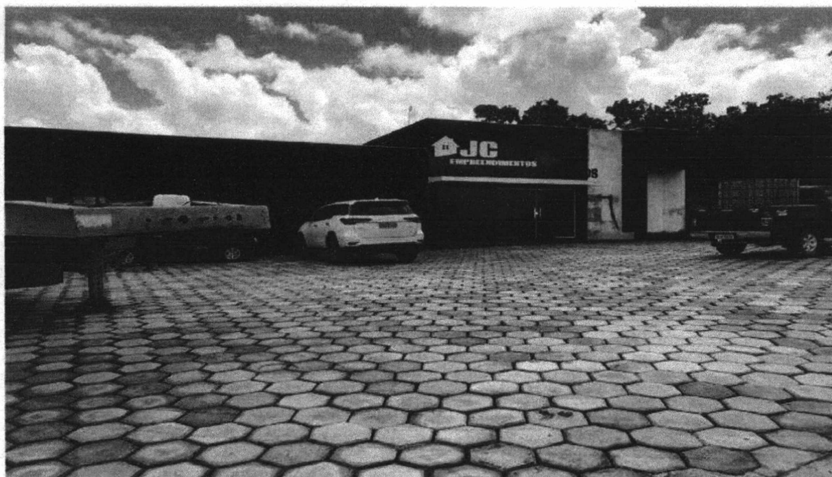
FOTO 03 – PARTE EXTERNA (GARAGEM)
